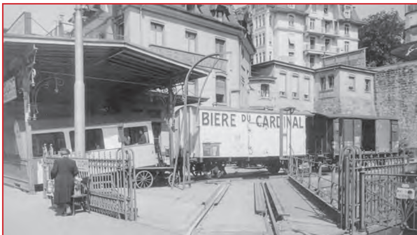
L'inclinaison de la voiture voyageurs est destinée à détendre le câble menant au Flon.
