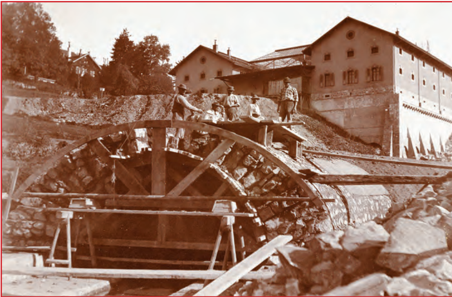
Le voûtage du Flon et le remblaiement du vallon vers 1890. À l'arrière-plan l'entrepôt fédéral, futur port franc.
